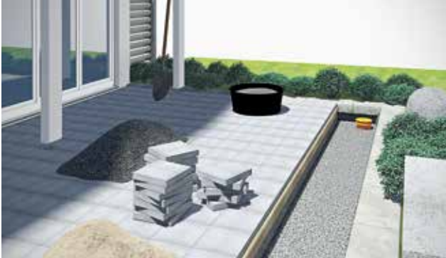
Cave una zanja en la que colocar el canal con una subcapa resistente a las heladas.
