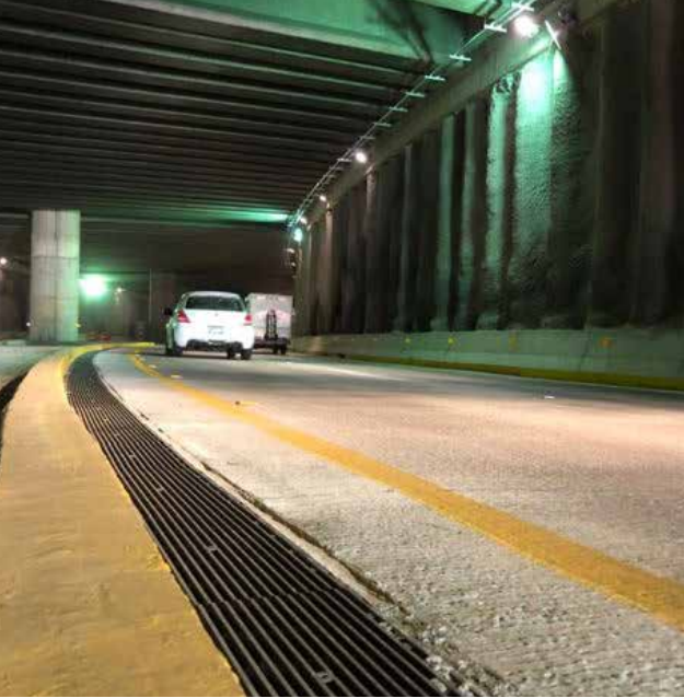
Autopista en Guadalajara, México
