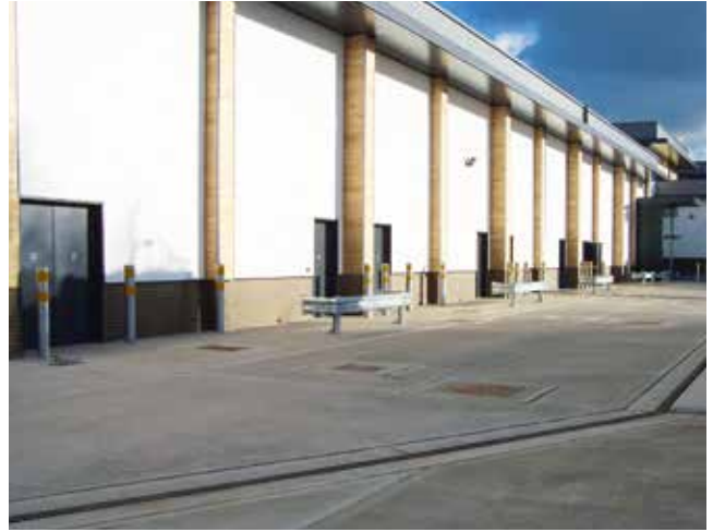
Instalación en superficie de hormigón
