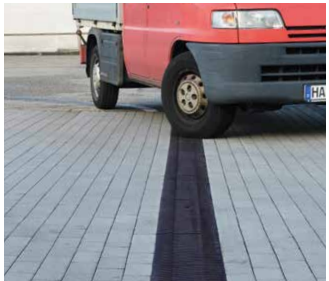
Instalación en superficies de pavimentación
