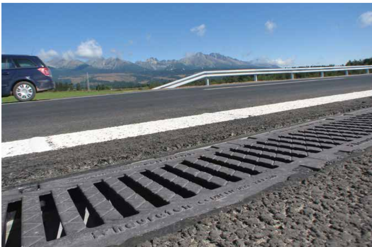
Drenaje de carreteras, Eslovaquia
